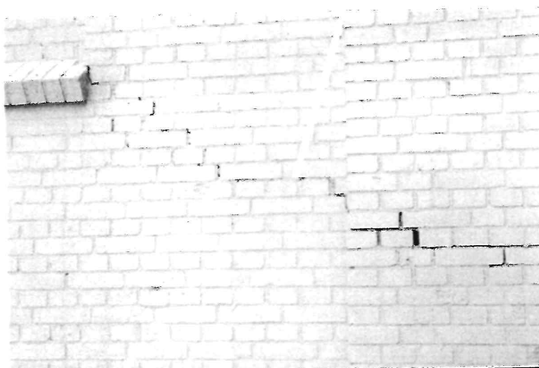
Окна фасад. Угол справа. Продольная косая трещина, величиной раскрытия до 1,5 см пролегает от угла до наружного подоконника крайнего правого окна.
