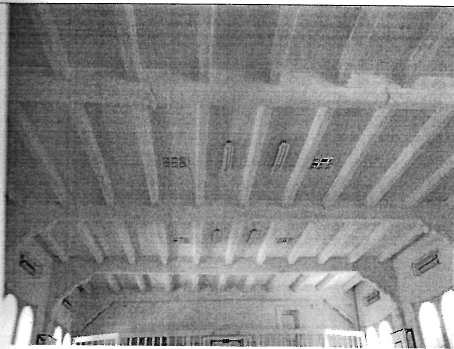
Интерьер спортивного зала деревянный, окрашен. Выполнен по системе продольно-поперечных деревянных балок с консолями.
