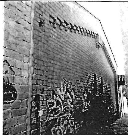
Западный фасад пристройки. К северной стене примыкает современный блок теплопункта.
