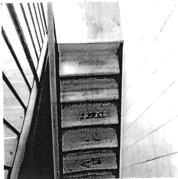
Лестница двухмаршевая по металлическим косоурам с металлическими перилами и деревянными ступенями.
