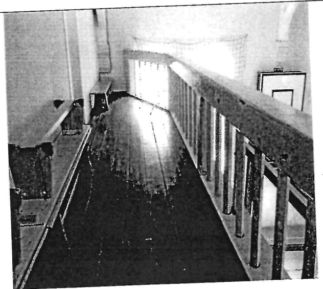
Спортивный спортзал. Вдоль восточной стены спортзала на уровне второго этажа сохранился деревянный балкон из шести деревянных резных стоек. Площадка балкона огорожена деревянными перилами в виде решётки, пол дощатый, окрашен. На балкон выходит дверь из служебных помещений.
