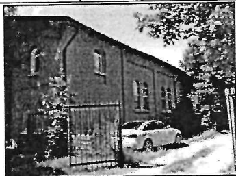
Северный фасад. Вид с северо-востока.
